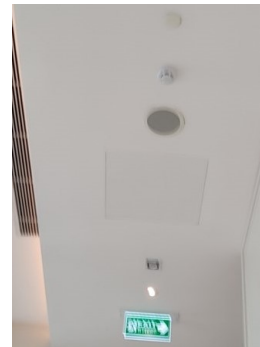
ระบบป้องกันอัคคีภัยและเตือนภัย ภายในห้องพักอาศัยและไฟฟ้าส่องสว่างฉุกเฉิน
