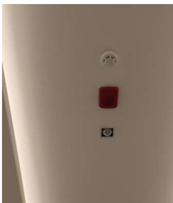
เครื่องตรวจจับควัน อุปกรณ์แจ้งเหตุหนีไฟ และเครื่องฟ่นละอองน้ำ
