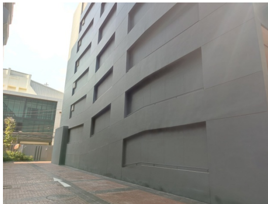
ภาพที่ 5-51 ปรับปรุงผนังอาคารจอดรถด้านทิศใต้ของอาคาร เป็นผนังกันเสียง ปิดทับป้องกันผลกระทบด้านเสียงจากอาคารจอดรถ ไปยังอาคาร ฟิเอสเจ อพาร์ทเมนต์ และอาคาร โรงแรม คราวน์ บีทีเอส นานา
